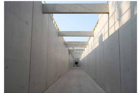
▲ Regen- und Kühlwasser werden im neuen Kanal sicher zur Lippe abgeleitet.
