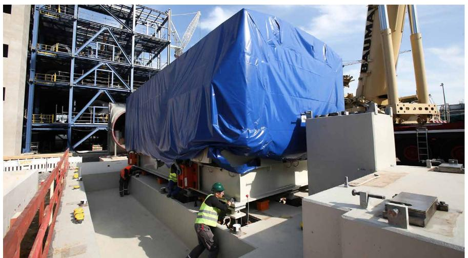
▲ Näherer Blick auf die Gasturbine – sie ist eine der zentralen Bau- und Funktionselemente des neuen GuD-Kraftwerkes.
