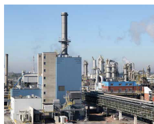
▲ GuD-Kraftwerk IV: Seit 2016 (erstes GuD in Marl)
