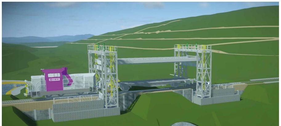
▲ Modell für die Zukunft: Ein solches Traggerüst kommt zum Einsatz, wenn eine neue Brücke „eingehoben“ wird, so wie am Silvertbach. Das Modell ist eine Vorschau auf die Zukunft – in rund 1,5 Jahren soll die Brücke einsatzbereit sein.
