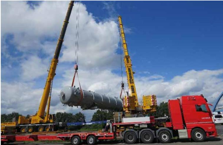
▲ Entladung des Reaktors C-1240 mittels Tandemhub.
