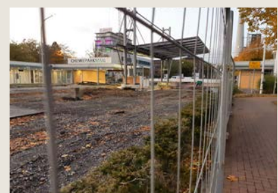
Tor 1 heute, kurz nach Beginn der Bauarbeiten.
