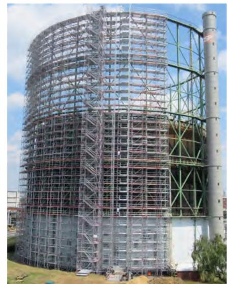
von Transportbühnen und Aufzügen, mit einer zulässigen Traglast von bis zu 2.500 kg, für einen schnellen und sicheren Personen- und Materialtransport in große Höhen. Dieses musste speziell in der Konstruktion und der Statik dieser Mega-Gerüste berücksichtigt werden.
