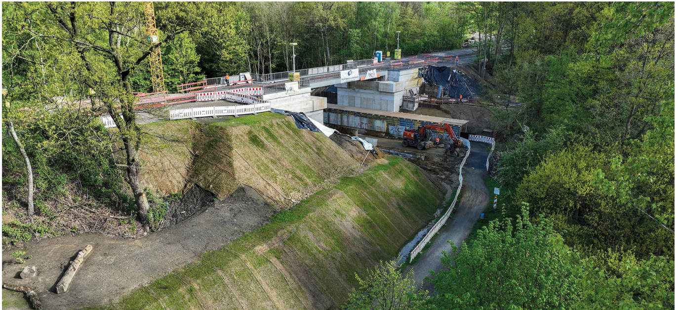
▲ Brücke, Bachlauf, Fahrradweg: Im Sommer soll das Bauprojekt abgeschlossen sein.
