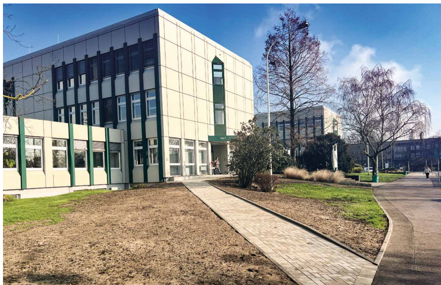
▲ Ebenerdig und zielführend: Der neue barrierefreie Weg zu einem der Verwaltungsgebäude im Chemiepark Marl
