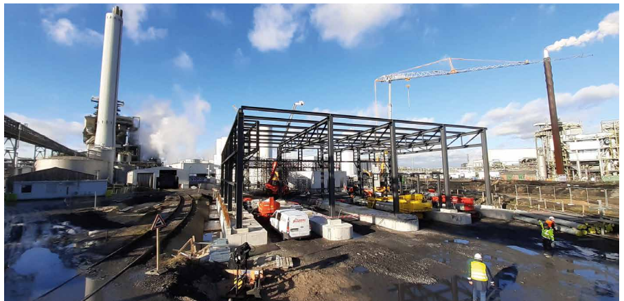
Die neuen Anlagen nehmen Formen an: Ein bereits im Bau befindliches Tanklager und eine Verladestation, die schon in der Übergangsphase der Entsorgungssicherheit des Chemieparks dienen, sollen logistisch in die Gesamtanlage integriert werden.
