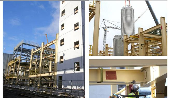
**Die Fundamente des neuen Polyamid-12-Komplexes in Marl sind gegossen, der Stahlbau aller Teilprojekte wächst und auch die ersten Apparate sind bereits installiert.**
