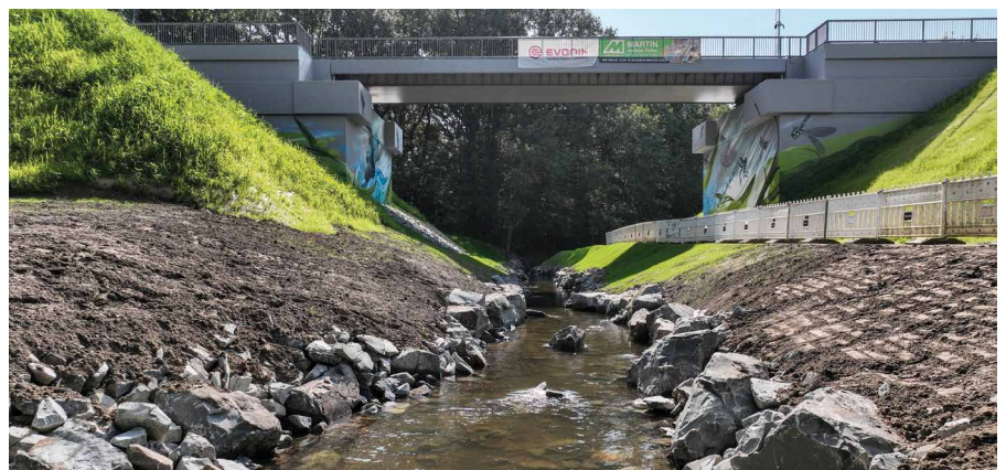
▲ Renaturiert und von neuer Brücke umrahmt: Der Silvertbach in Marl-Hüls.
